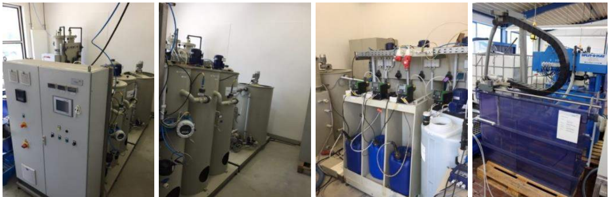
Abbildung 73: Modular aufgebaute Pilotanlage mit Sedimentation oder Elektroflotation (v.l.n.r.: Gesamtanlage mit Schaltschrank; Fällungs- und Flockungsstrecke mit Sedimenter im Hintergrund; Chemieansatz- und Dosierstation; Elektroflotation)
