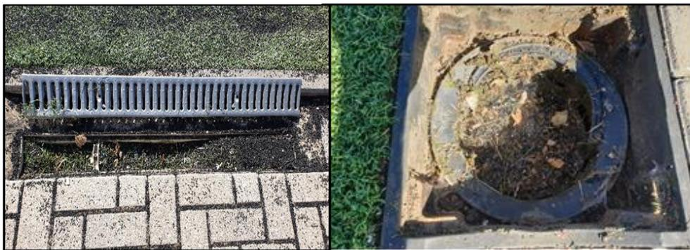
Abbildung 11: verstopfte Abläufe durch fehlende regelmäßige Wartung
